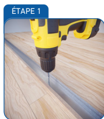
Installation d'une ossature métallique standard
