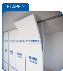
Pose rapide de l'isolant entre les montants métalliques
